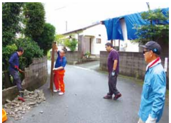
危険なブロック塀の撤去にあたる
