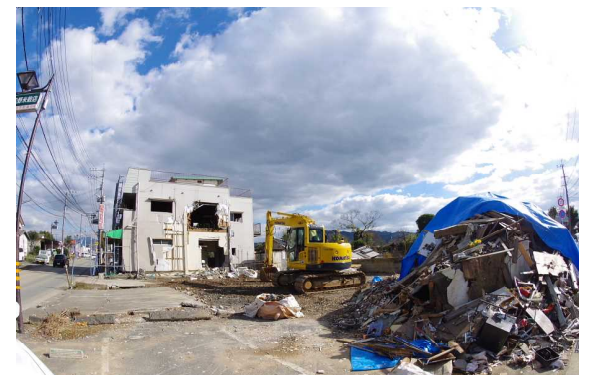
益城町 解体がすすみ空地が増えていく
